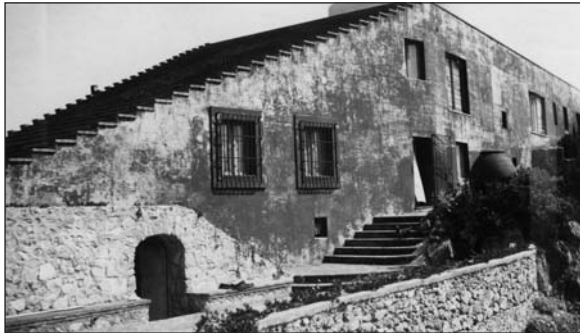
Façade de la Casa Come Me
